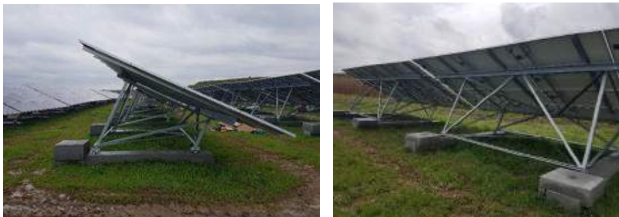
Exemple de fondations béton – Q ENERGY France
